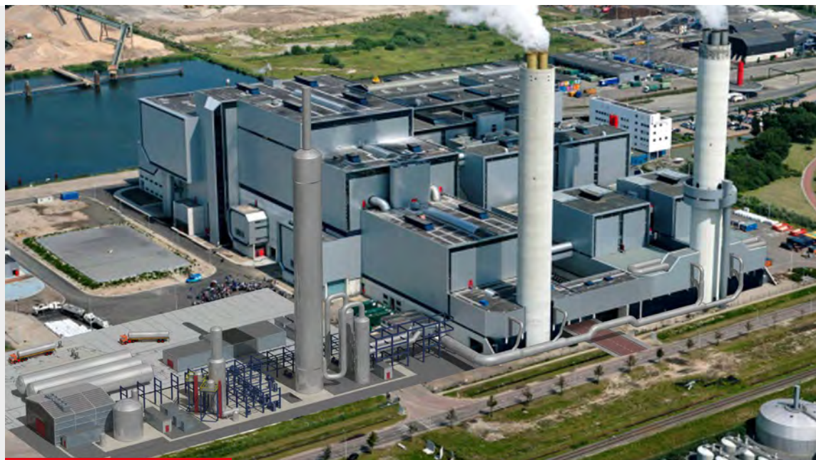
Artist impressions van AEB, met links op de voorgrond de CO 2 afvang installatie, inclusief nieuwe schoorsteen.
